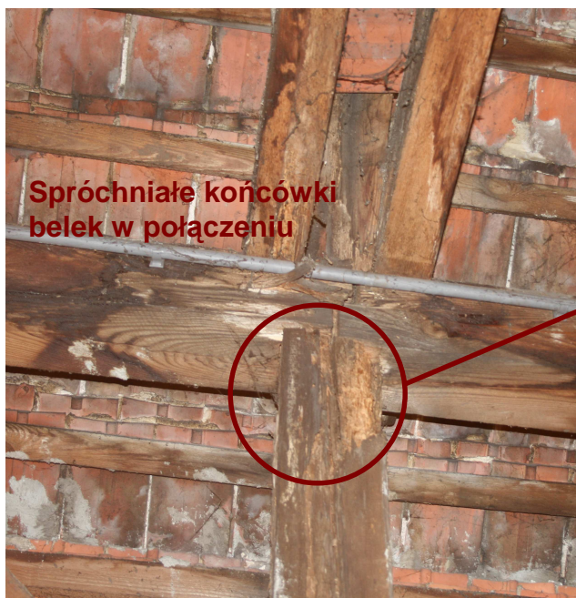
Fot. nr 4 Zniszczony przez owady i korozję biologiczną węzeł (płatew, słup, krokwie, kleszcze)
