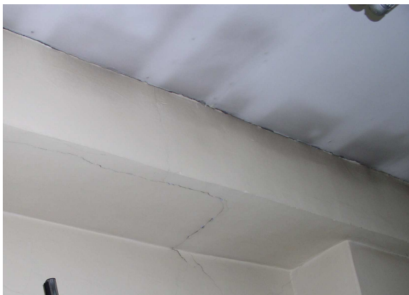
Fot. nr 3 Widoczne przemarzanie na suficie i znaczne uszkodzenia – sala 235
