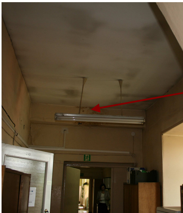
Fot. nr 1 Zacieki i rysy na ścianach przyczyną nieszczelności w pokryciu dachowym, a tym samym gnicia belek konstrukcji dachowej wewnątrz obudowy.
