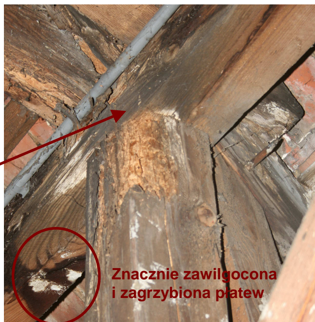
Fot. nr 4 Zniszczony przez owady i korozję biologiczną węzeł (płatew, słup, krokwie, kleszcze)
