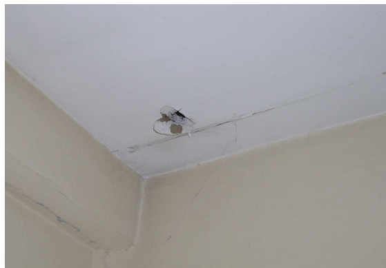
Fot. nr 3 Widoczne przemarzanie na suficie i znaczne uszkodzenia – sala 235
